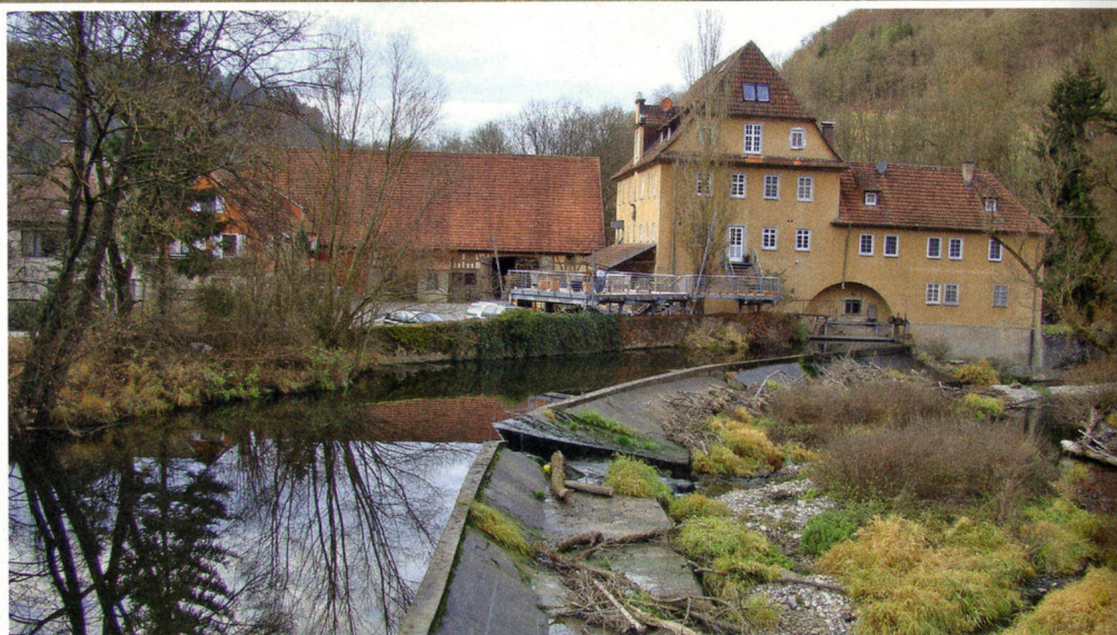
Das Wasserkraftwerk Ley liefert pro Jahr 120.000 kW Strom.
